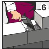
**6** Нанесите раствор на монтажную поверхность блока зубчатым шпателем или специальной кельмой. Следующий блок положите на клей и прижмите блоки друг к другу поворотным движением. Клей наносится на площадь, которую можно уложить в течение 5 минут (открытое время). Скорректируйте уложенные блоки в течение 5 минут после укладки (при t до -10°C).
