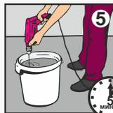
**5** Засыпая сухую смесь в воду, перемешивайте раствор дрелью со специальной насадкой на низких оборотах до получения однородной массы. Подождите 2-3 минуты, после этого перемешайте вторично. Раствор находится в рабочем состоянии не менее 30 минут (при температуре воздуха до -10°C). Температура растворной смеси в процессе проведения работ должна быть не ниже +5°C.
